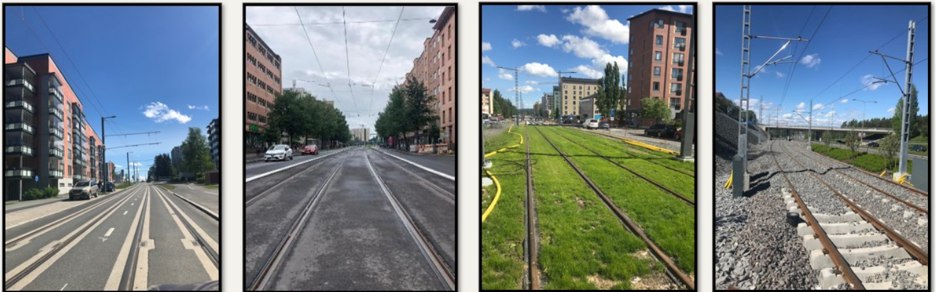
Kuva 5. Päällysrakenteet vasemmalta oikealle: sekaliikennerrata, raitiotierata, nurmirata ja sepelirata.
