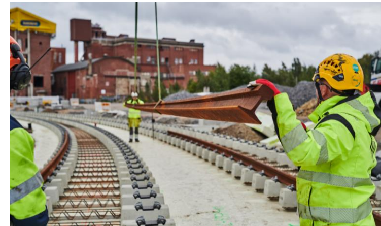
Rakentamisen aikana turvallisista kulkureiteistä viestitään ennakoivasti.
