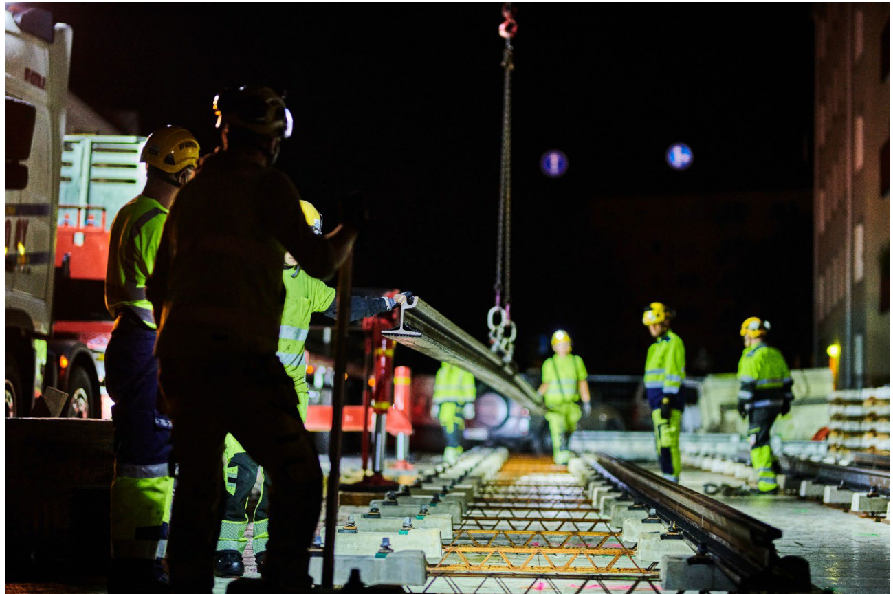
Kiskojen asentamista yötyönä. Kuva: Raitiotieallianssi / Wille Nyysönen.
