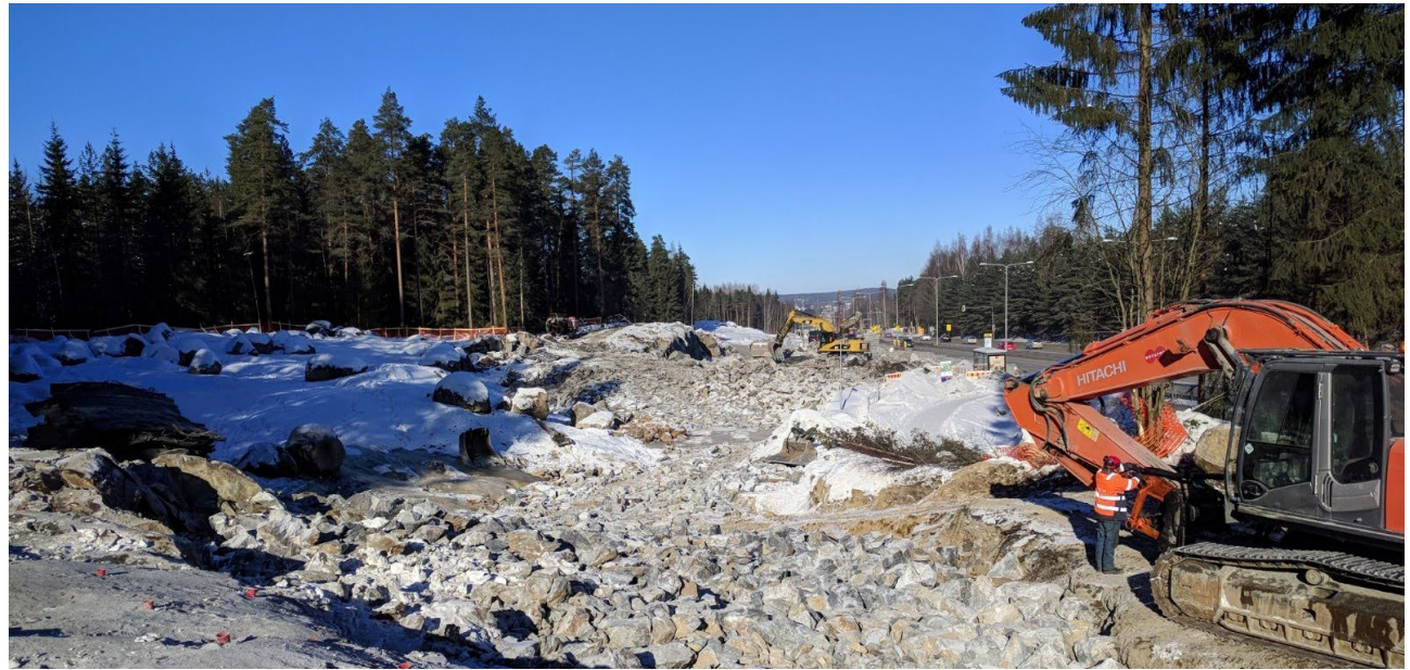
Kallion räjäytys- ja murskaustyöt käynnissä louhintakentällä. Kuva: Raitiotieallianssi.
