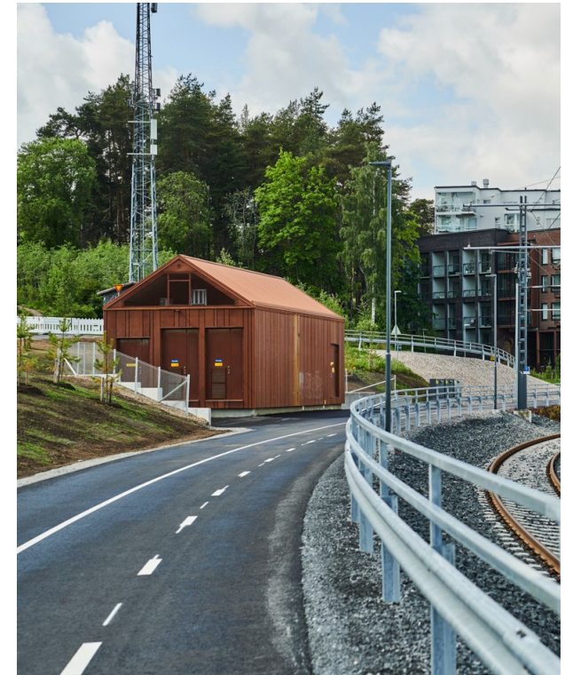
Paasikivenkadun sähkönsyöttöasema. Tampereen Ratikan sähkönsyöttöasemien julkisivumateriaali on Corten-teräs. Kuva: Raitiotieallianssi.
