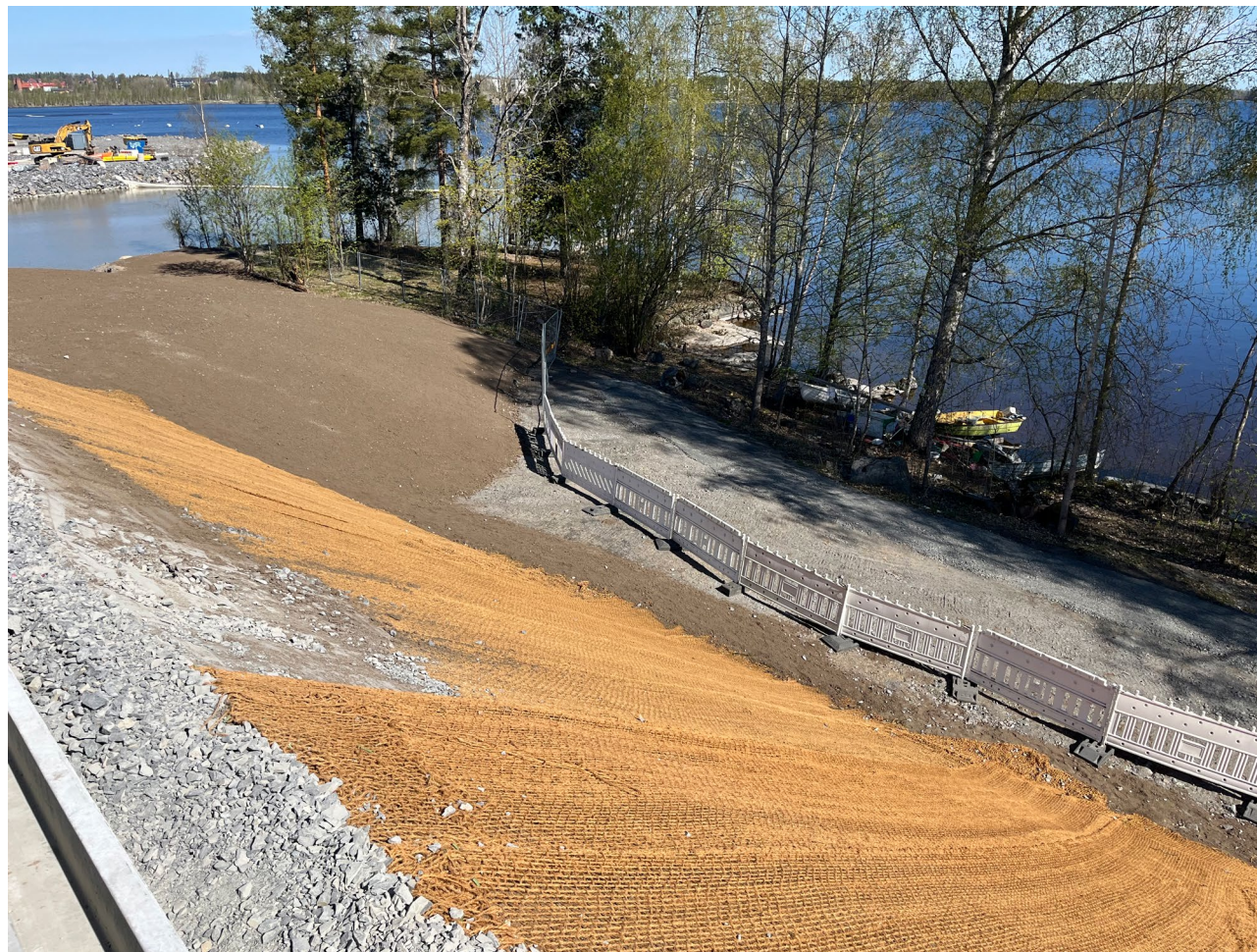
Pölkylänsillan penkereen eroosiomatto sitoo pintamaan, kunnes paikalle istutettava kasvillisuus juurtuu. Kuva: Raitiotieallianssi.
