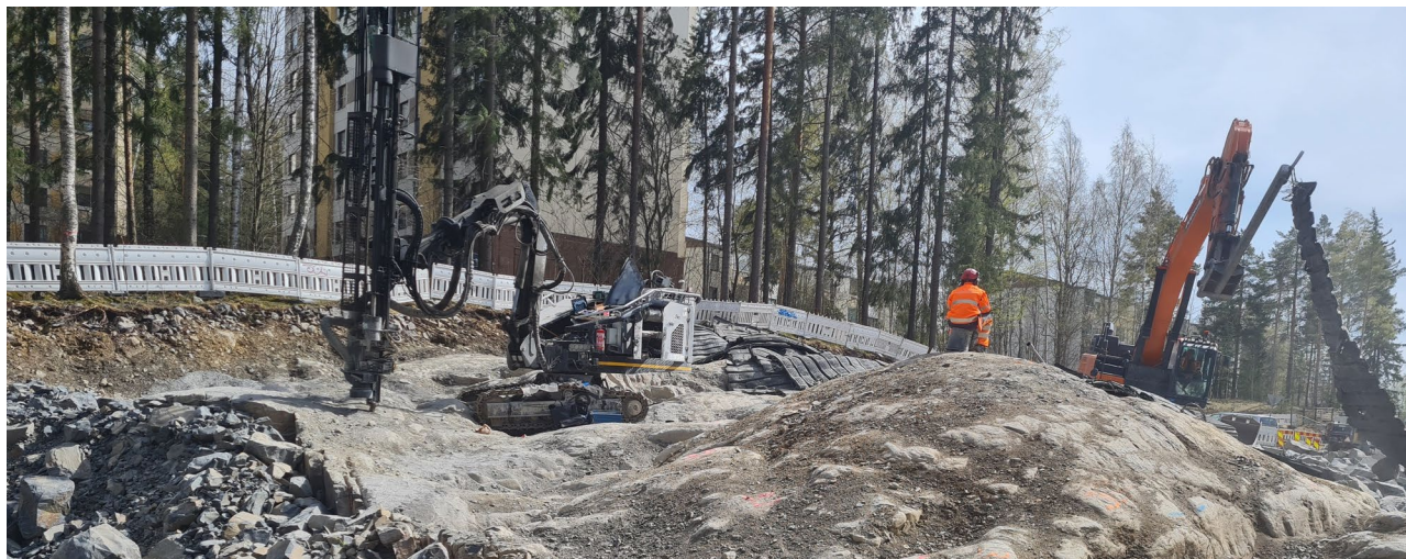
Louhintaan liittyvä poraustyö käynnissä. Kuva: Raitiotieallianssi.
