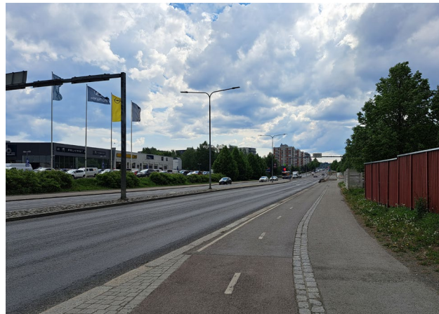
Hatanpään valtatiellä eteläpäässä katuvihreän osuus vähenee merkittävästi. Taustalla erottuvat Kolmionkadun pistetalot. Kuva: Tampereen Ratikan Pirkkala–Linnainmaa -allianssi.
