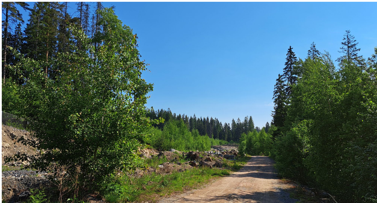
Lääkärikadun jatke on puhkaistu maastoon, mutta alue toimii varastoalueena. Kuva: Tampereen Ratikan Pirkkala-Linnainmaa -allianssi.
