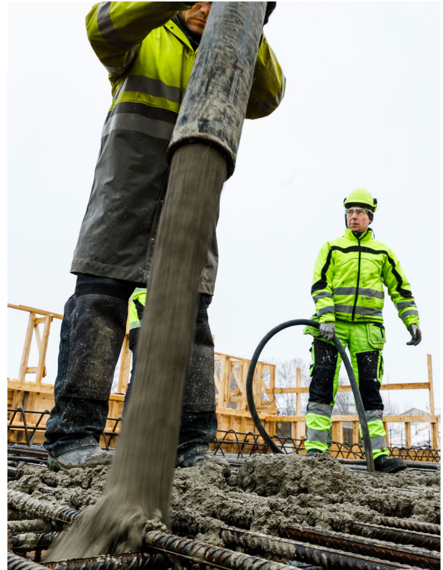
Hallinojan ratasillan valua Hervannan valtavyölyän varrella keväällä 2019. Kuva: Raitiotieallianssi / Pasi Tiitola.
