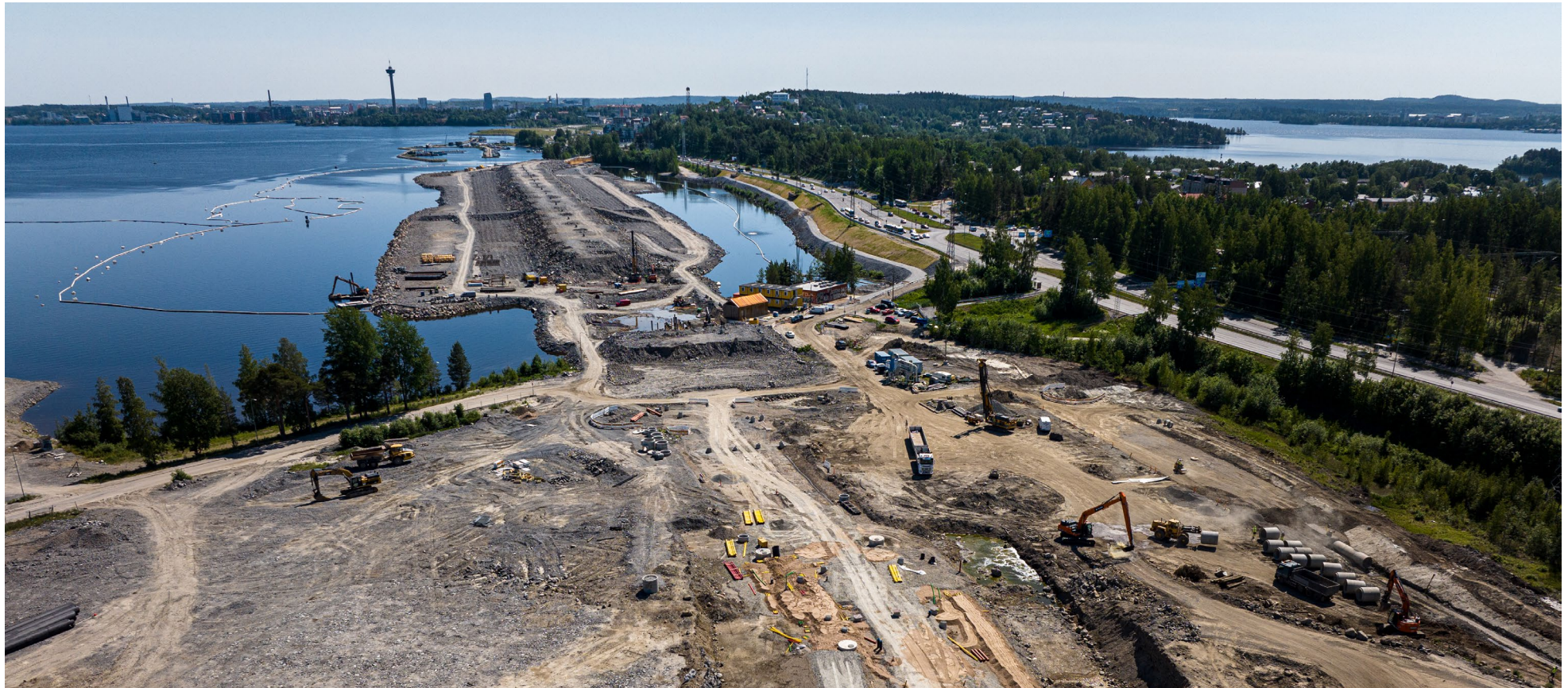
Santalahdesta Hiedanrantaan raitiotietä rakennettiin osittain pohjavesialueella. Kuva: Raitiotieallianssi / Pasi Tiitola.
