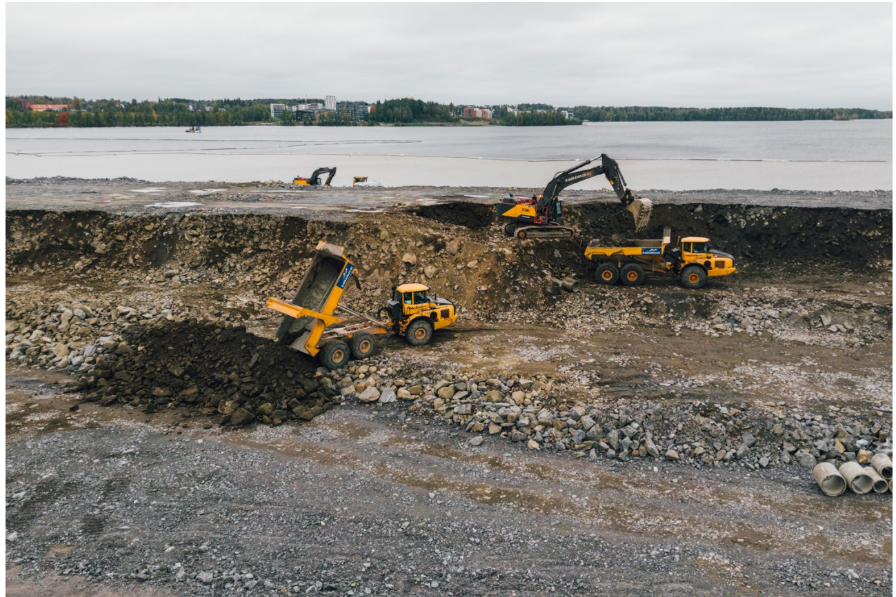
Painopenkereen purkua Näsisaassa. Kuva: Raitiotieallianssi / Wille Nyssönen.
